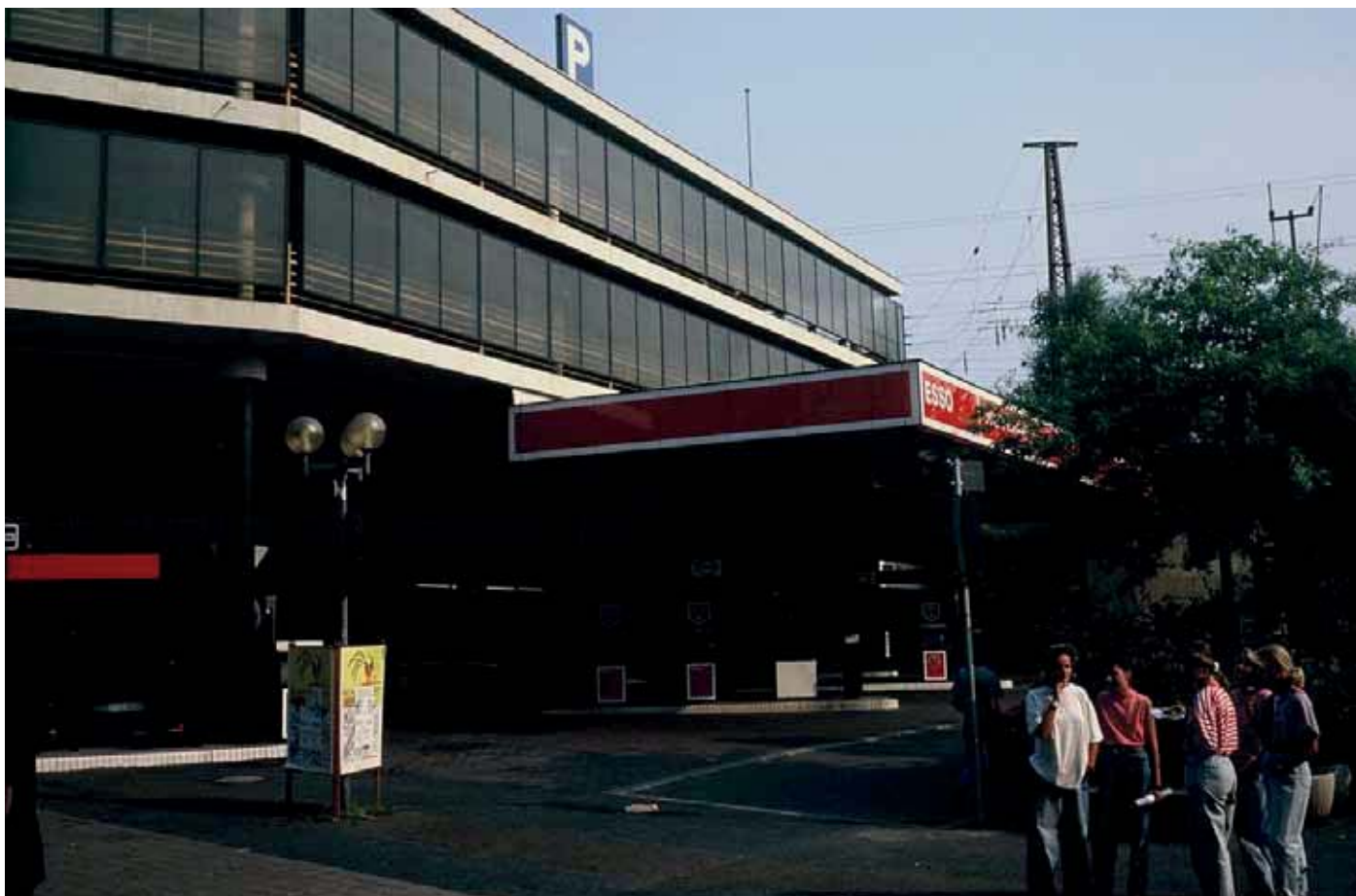
Die ehemalige Tankstelle direkt am Konrad Adenauer Platz
